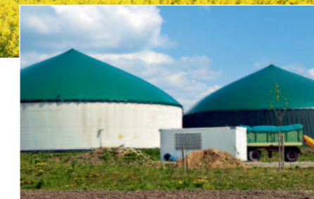
Bioplynové zařízení slouží k výrobě bioplynu prokvašením biologické hmoty.
