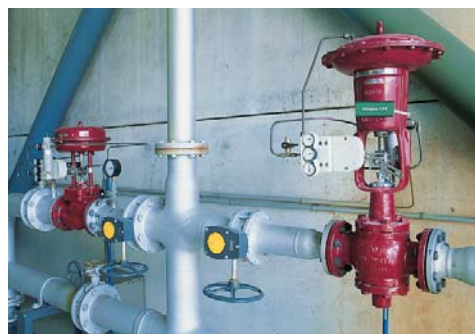
Einsatz von NOVATEC® Premium in Salzgewinnungsanlage
