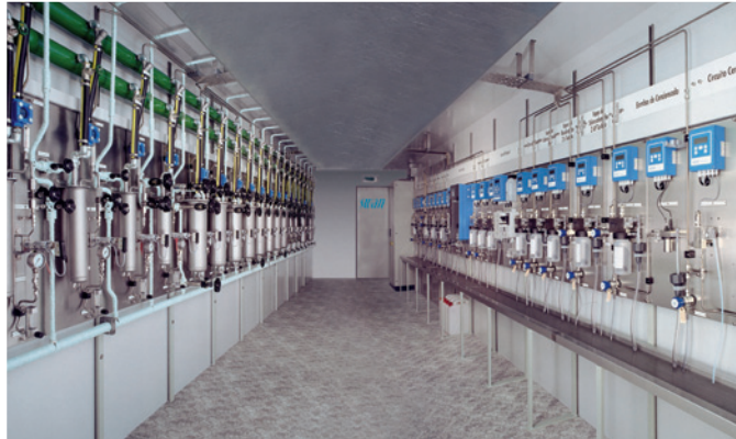
Analysegeräte in typischer Anordnung in einer Gesamtanlage für ein Dampfkraftwerk
