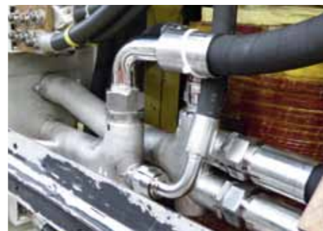
Verbindung mehrerer Stromrichter-Kühlschläuche
