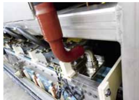
Spezielle, doppelt gebogene Verbindungsschläuche (90°) mit Schrumpfschlauchmuffen für eine bessere elektrische Isolierung
