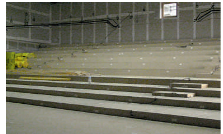
Les patins en polyuréthane expansé d'épaisseur variable absorbent le son et les vibrations.
