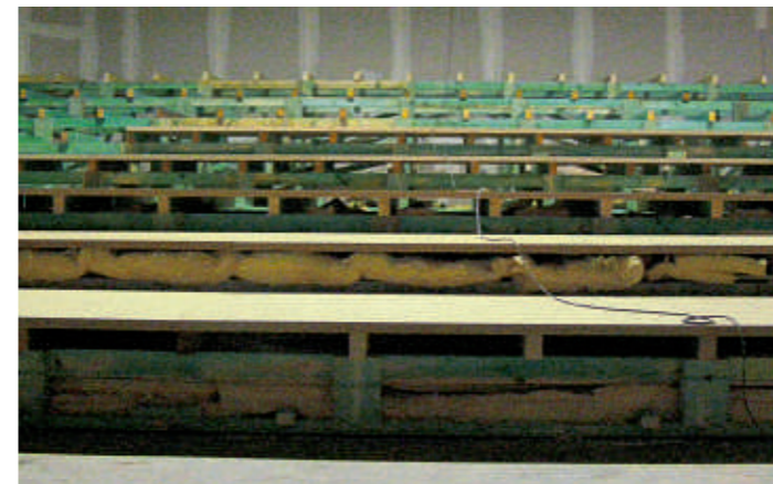
Un montage aisé, aucun temps de séchage : les gradins en bois présentent des avantages.
