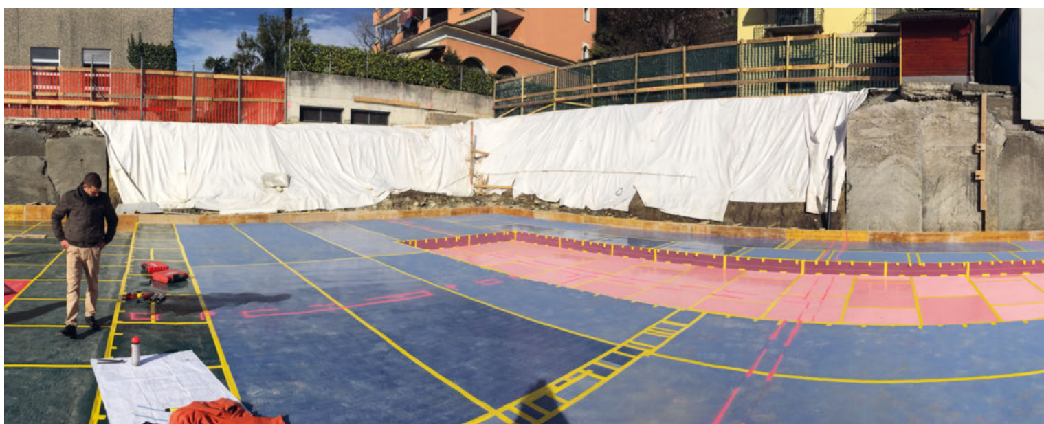
Una villetta plurifamiliare è in fase di costruzione proprio sopra un tunnel ferroviario. Per fare in modo che le vibrazioni per via dei treni non fossero trasferite alla casa, l'edificio è stato provvisto di un basamento elastico.
