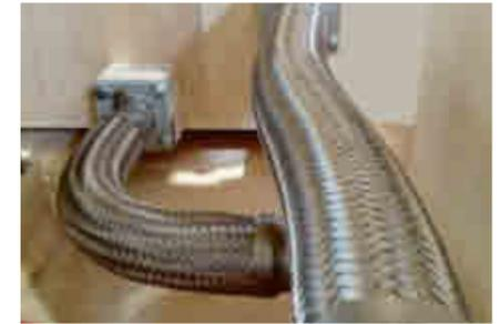
Tuyau flexible pour l'aller et le retour, branchement côté transformateur.
